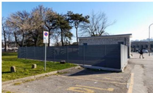
Presidio della Polizia Locale a Campo Marzo
